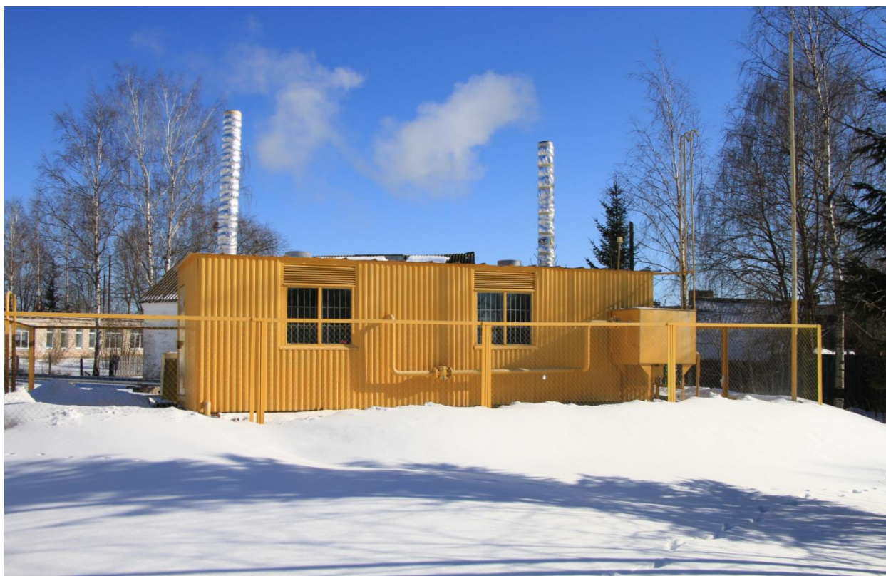
Рис.6. Внешний вид котельной
